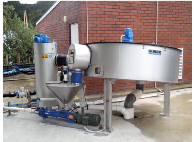
Außenaufstellung eines HUBER Scheibeneindickers S-DISC.
